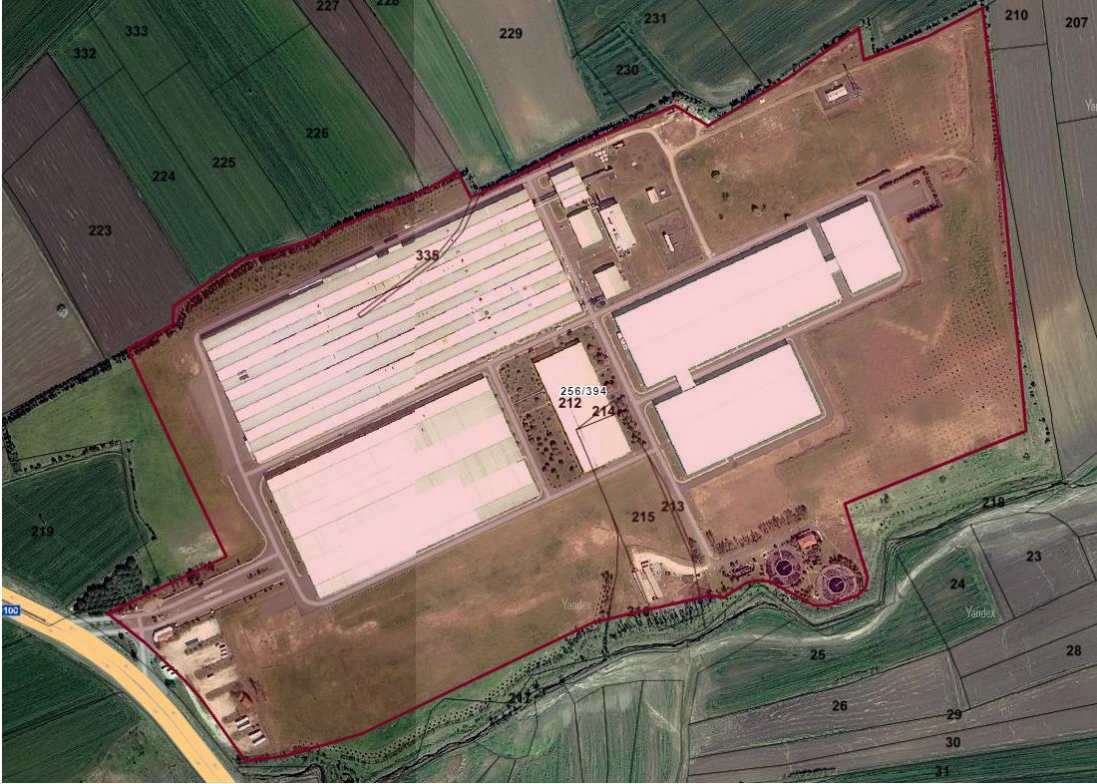
Tesis ve komşu parsellerin görünümü
